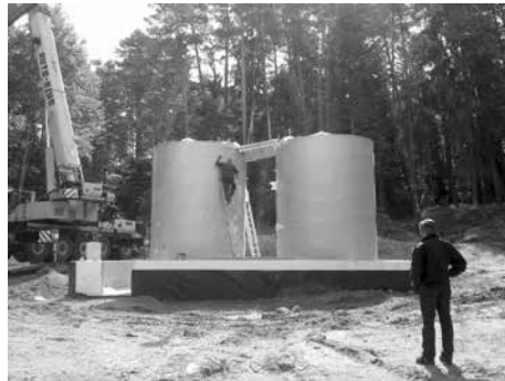
Lieferung der Tanks für Hochbehälter Baiersdorf
