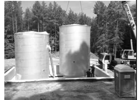
Lieferung der Tanks für Hochbehälter Baiersdorf
